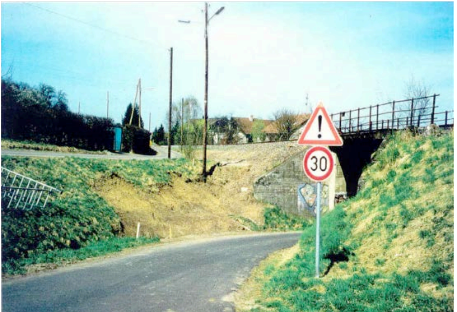
Bild 9: Brückenbauwerk an der Strecke Böblingen - Dettenhausen zu DB-Zeiten
