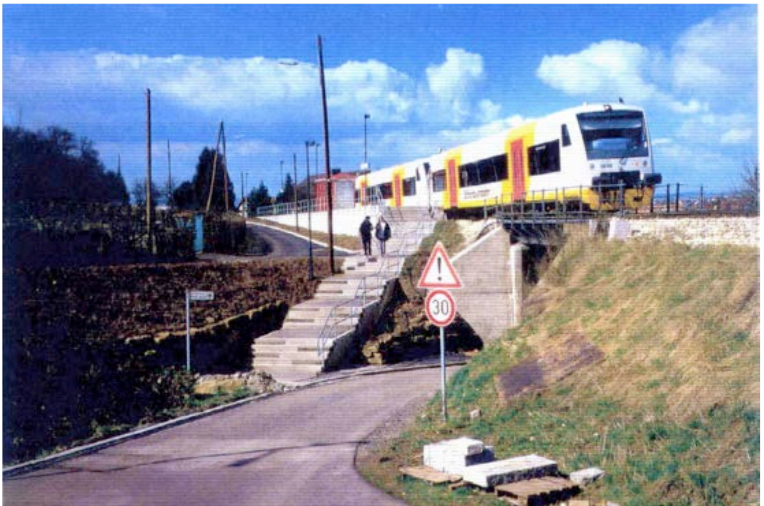
Bild 10: Haltepunkt und Brückenbauwerk nach Reaktivierung der Strecke Böblingen - Dettenhausen
