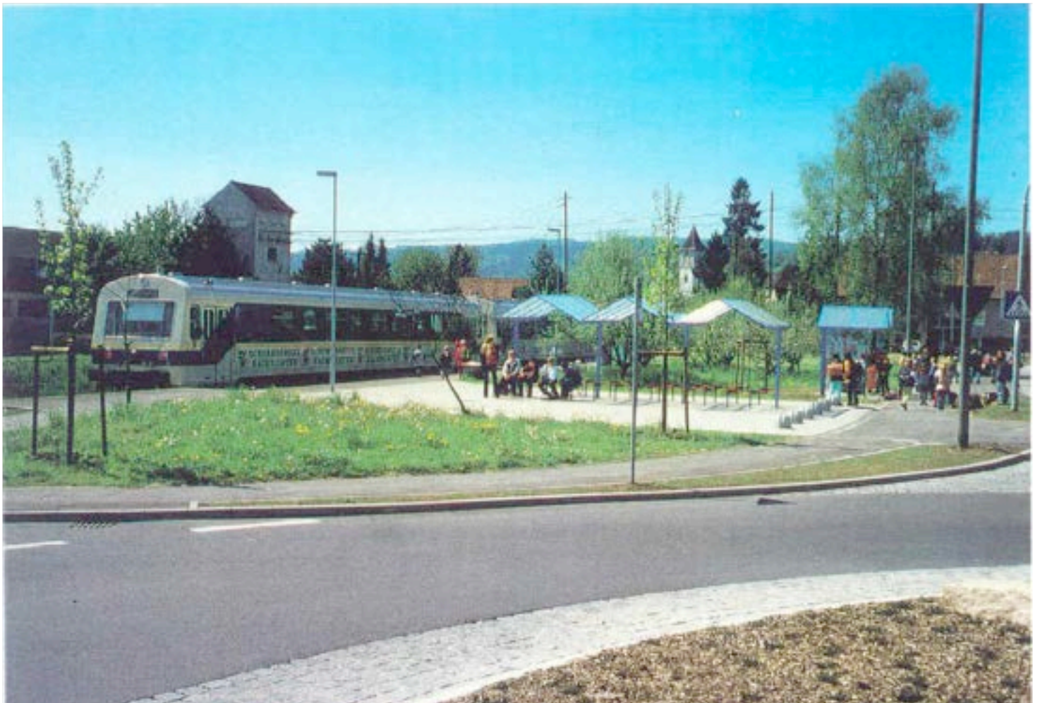
Bild 5: Gesamtansicht einer neuen Haltestelle an der Strecke Schorndorf - Rudersberg
