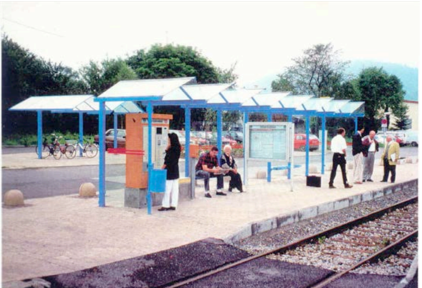
Bild 3: Neue Haltestelle an der Strecke Schorndorf - Rudersberg
