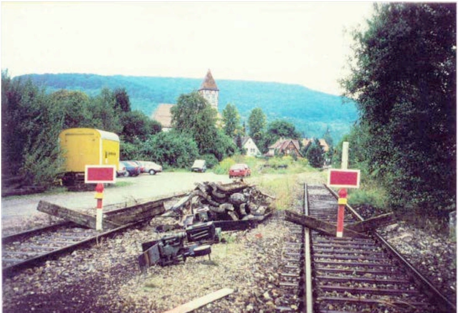
Bild 1: Ende der ehemaligen DB-Strecke Schorndorf-Rudersberg vor der Übernahme durch die SWEG
